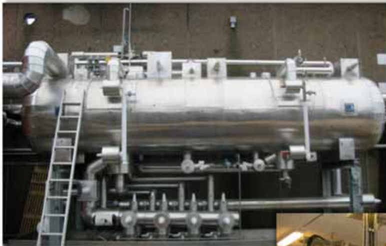
oben: NH 3 -Abscheider des Betreibers im Außengelände
