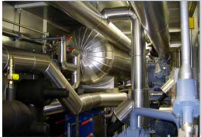
40' Container mit CO 2 / NH 3 -Erdgefriercontainerkälteanlage
