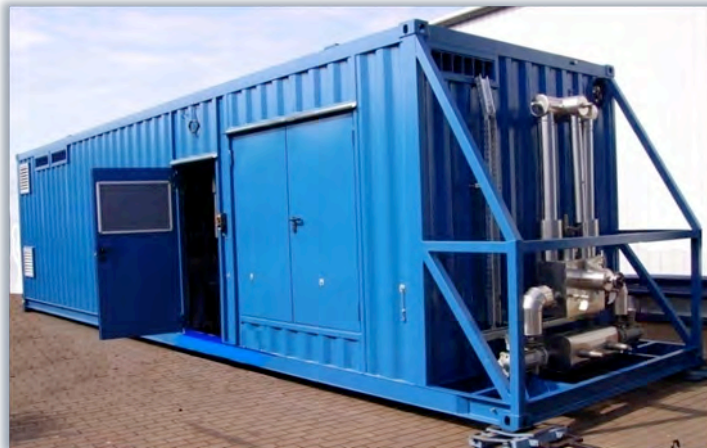
CO 2 / Propen-Kaskadenkälteanlage im Container, beinhaltet u.a. CO 2 -Verdichteraggregate als Unit
