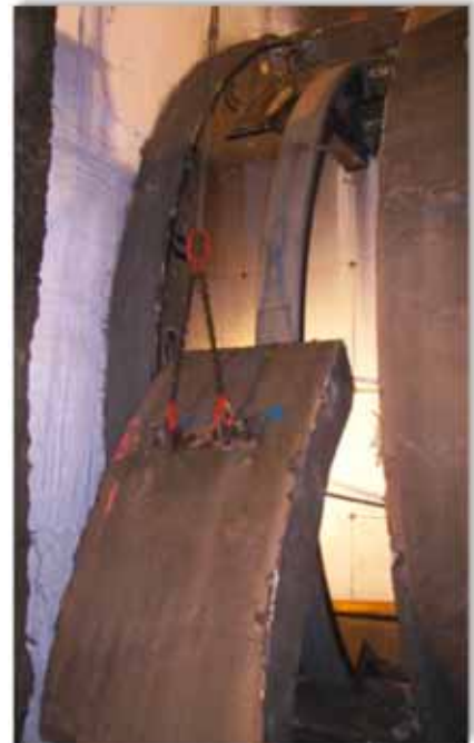
Gefrorenes Erdreich (weiß) um Tunnelröhre, die zur Verbindung mit einem U-Bahnhof unter Schutz des
